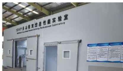
10HP多功能双焓差性能试验室
