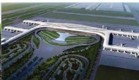
武汉天河机场T3航站楼
